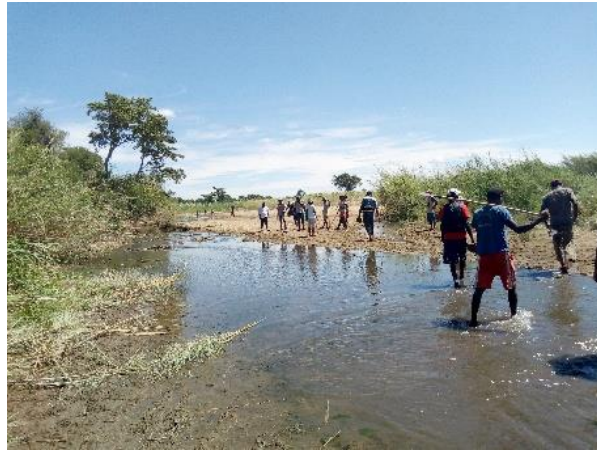
Photo 1 : Vue de l'emplacement du barrage à construire à Andakato amin'i Zafipiera
